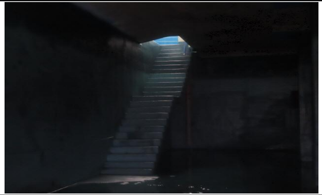
배수지 2지 안전난간 미설치
