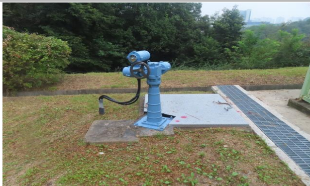
유입밸브실 1지 덮개 상태양호
