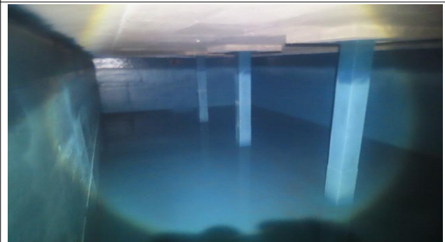
배수지 1지 내부 전경 (2023년)
