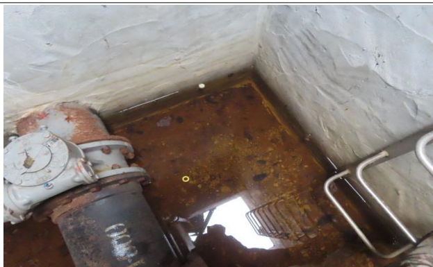
유입밸브실 2지 하부슬래브 체수
