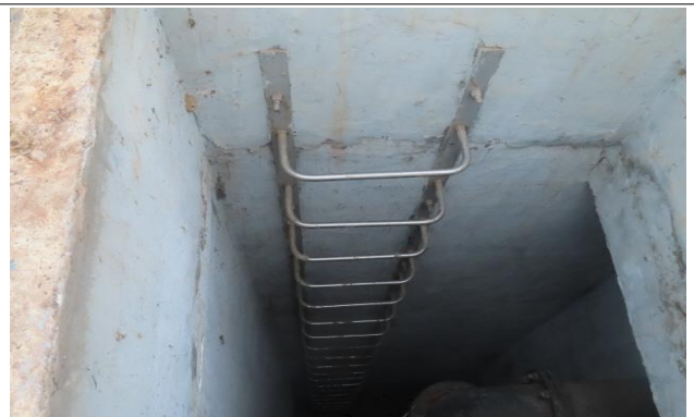
유입 밸브실 2지 수직형 사다리 상태양호
