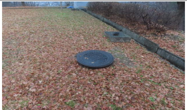
유량계실 덮개 상태양호
