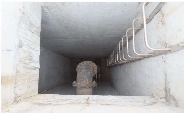
유출 밸브실 2지 수직형 사다리 상태양호
