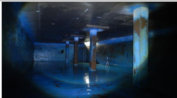
배수지 1지 내부 전경 (2021년)
