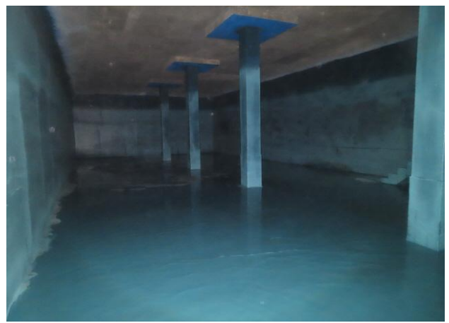
배수지 내부 전경
