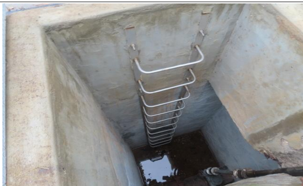
유입 밸브실 1지 수직형 사다리 상태양호
