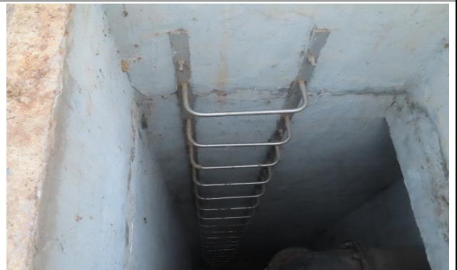
유입 밸브실 2지 수직형 사다리 상태양호
