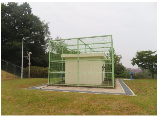
배수지 외부 전경
