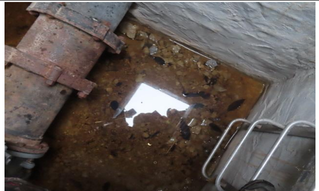
유입밸브실 1지 하부슬래브 체수
